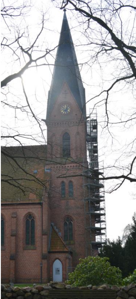
Seit fast zwei Jahren eingerüstet: Der Ramelsloher Kirchturm
